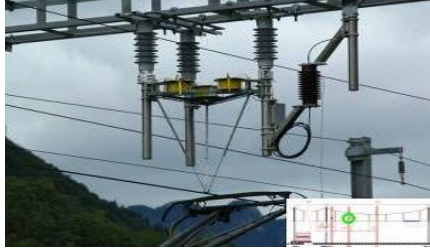
Figure 2a. Tétraèdre formé de 3 capteurs de déplacements à réseau de Bragg
