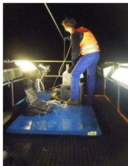
Fig. 4a : Opération de collage d'une ligne de mesure à réseaux de Bragg sur la ligne de contact
