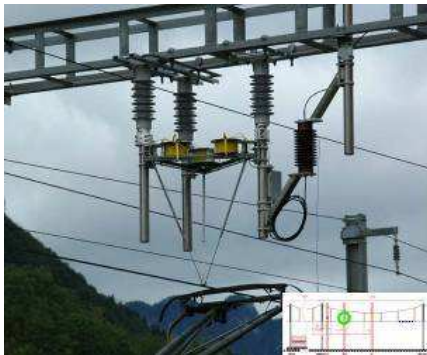
Fig. 3a : Capteur de déplacement 3D
